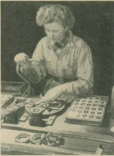
**Bild 6: Arbeitsplatz am Fließband mit der Kluppe zum Einbinden der einzelnen Zellen**
